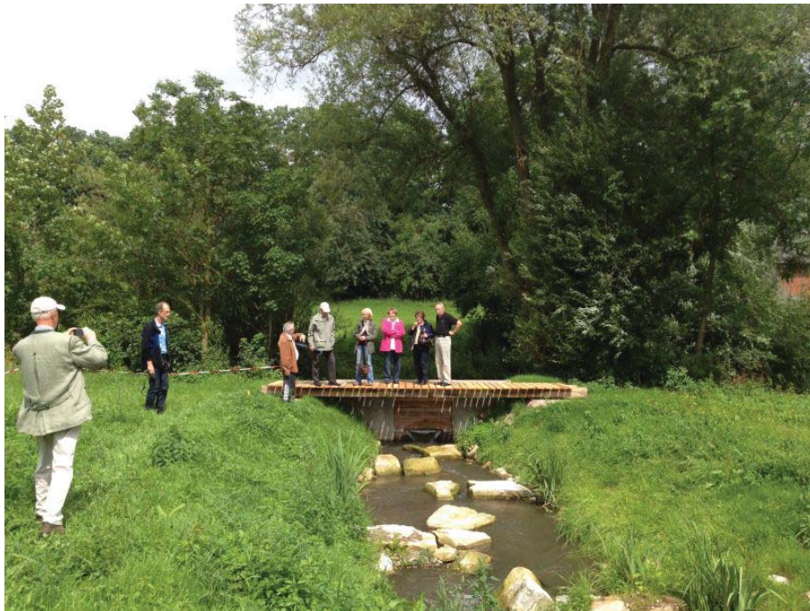
Bild Nr. 966: Blick auf den Einlaufbereich der Fischaufstiegsanlage am Ufer der Baunach, Ortstermin am 16.07.2012
