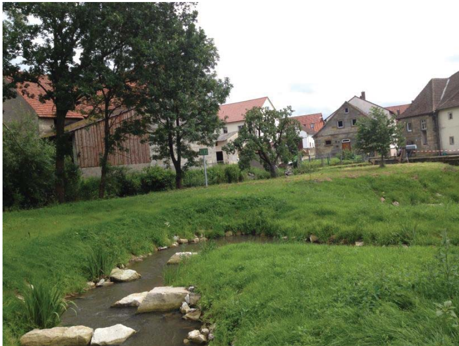
Bild Nr. 969: Blick von oberstrom auf die Fischaufstiegsanlage
