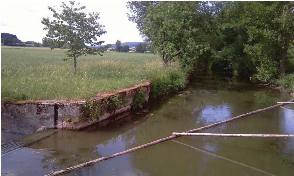
Bild Nr. 275: Wehranlage der Wasserkraftanlage Gräfenholz, Blick nach oberstrom auf die Baunach, vor der Errichtung der Fischaufstiegsanlage
