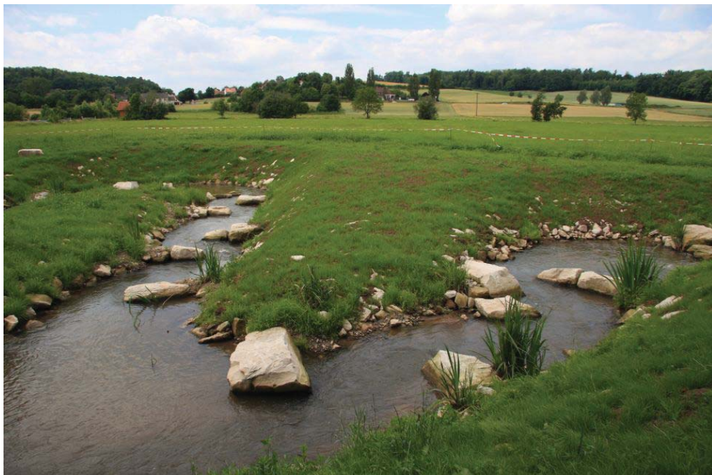
Bild Nr. 8887: Blick auf den Verlauf der Fischaufstiegsanlage
