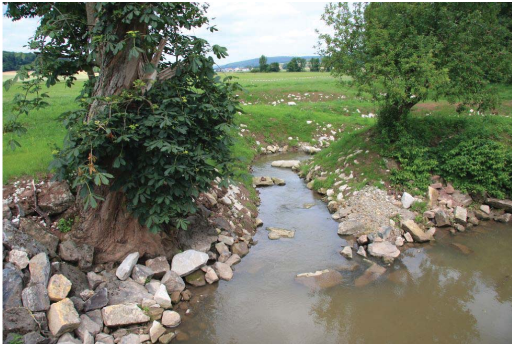
Bild Nr. 8846: Blick auf den Mündungsbereich der Fischaufstiegsanlage in die Baunach
