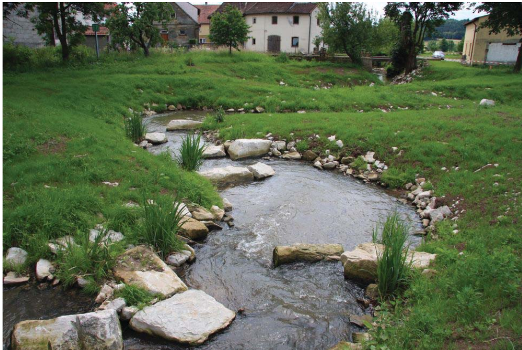
Bild Nr. 8877: Blick von oberstrom auf die Fischaufstiegsanlage
